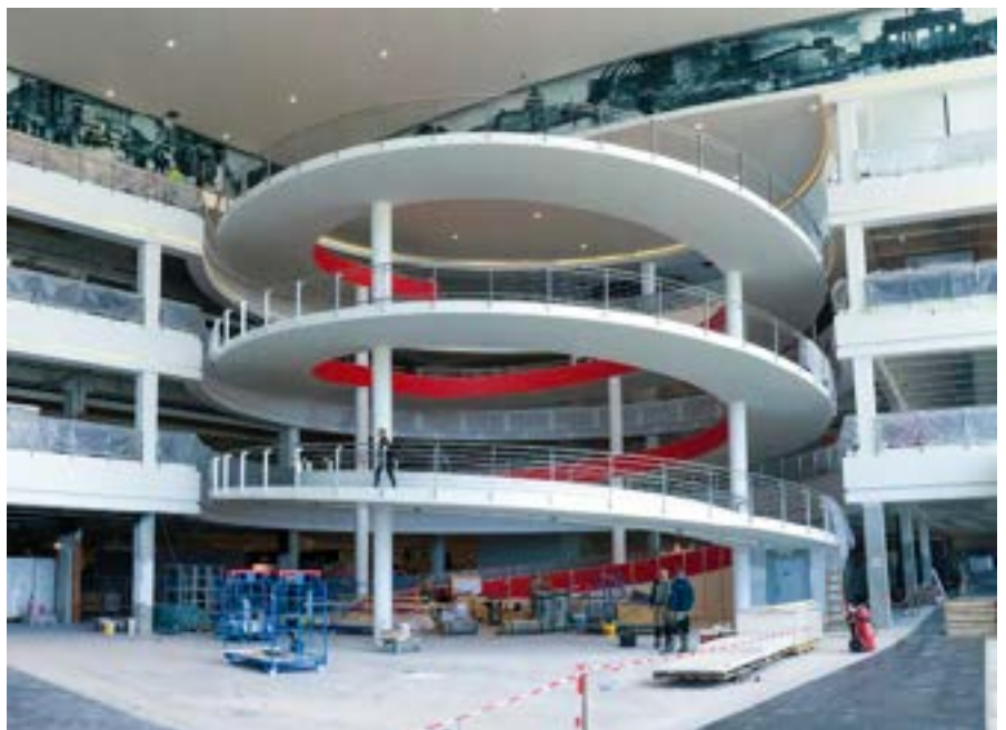
Durch den „Manitou“ konnte die Rotunde parallel zur Schließung der Dachhaut von innen fertiggestellt werden. Die Bauzeit wurde damit um 3 bis 4 Wochen verkürzt.
