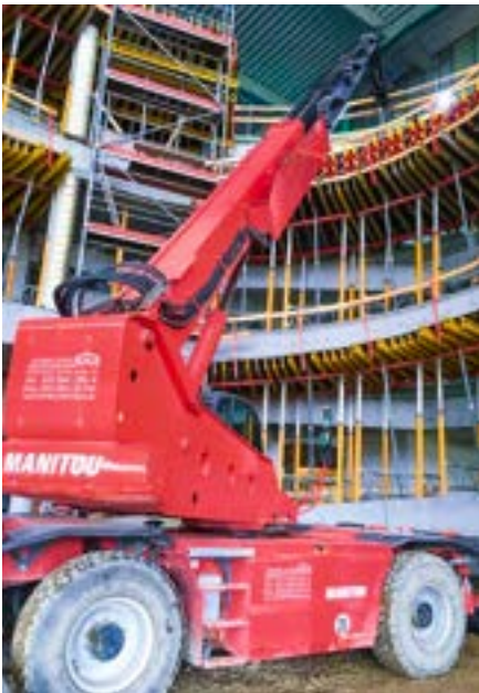
Durch den „Manitou“ konnte die Rotunde parallel zur Schließung der Dachhaut von innen fertiggestellt werden. Die Bauzeit wurde damit um 3 bis 4 Wochen verkürzt.
